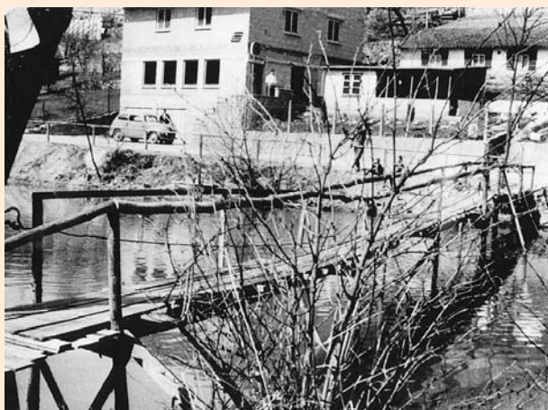
Oberer Steg: Behelfskonstruktion (um 1950)
