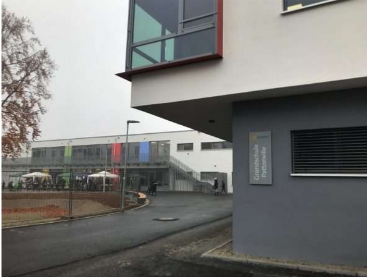
Abbildung 16: Grundschule Pattonville; Quelle: www.remseck.freiewaehler.de
